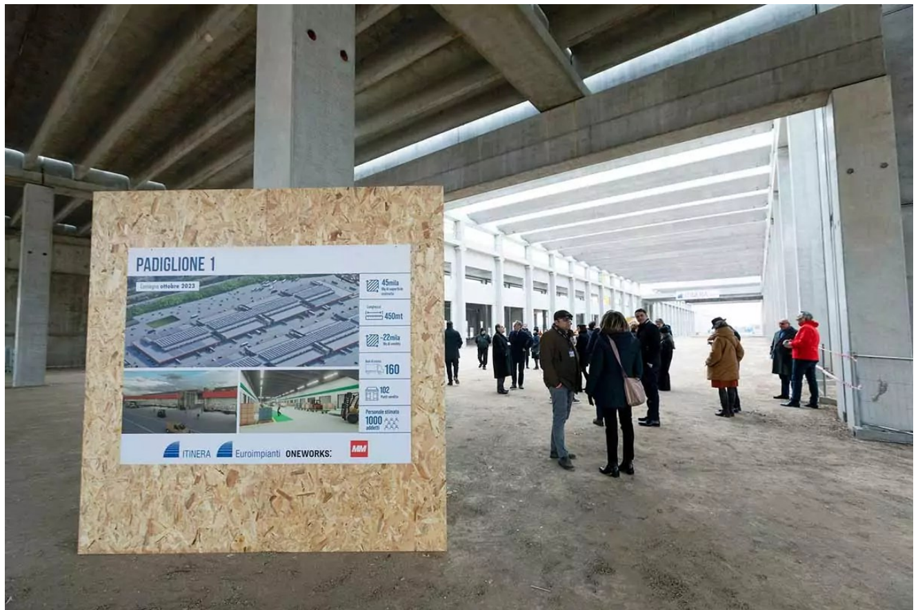
L'ingresso del Padiglione 1, in fase di costruzione (Facebook Sogemi )
